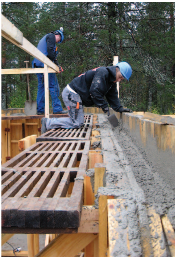
Jefferson McBell jevner ut toppen av støpen med Hannu Seppälä bakgrunnen
