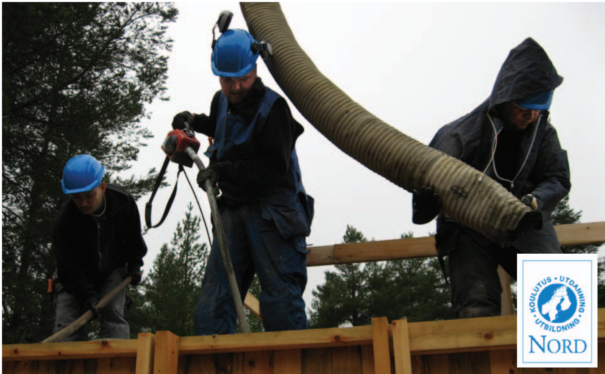
Jefferson McBell, Hannu Seppälä og Keijo Koivisto støper søppelstasjon på betongarbeider- utdanningen hos Utdanning Nord.
